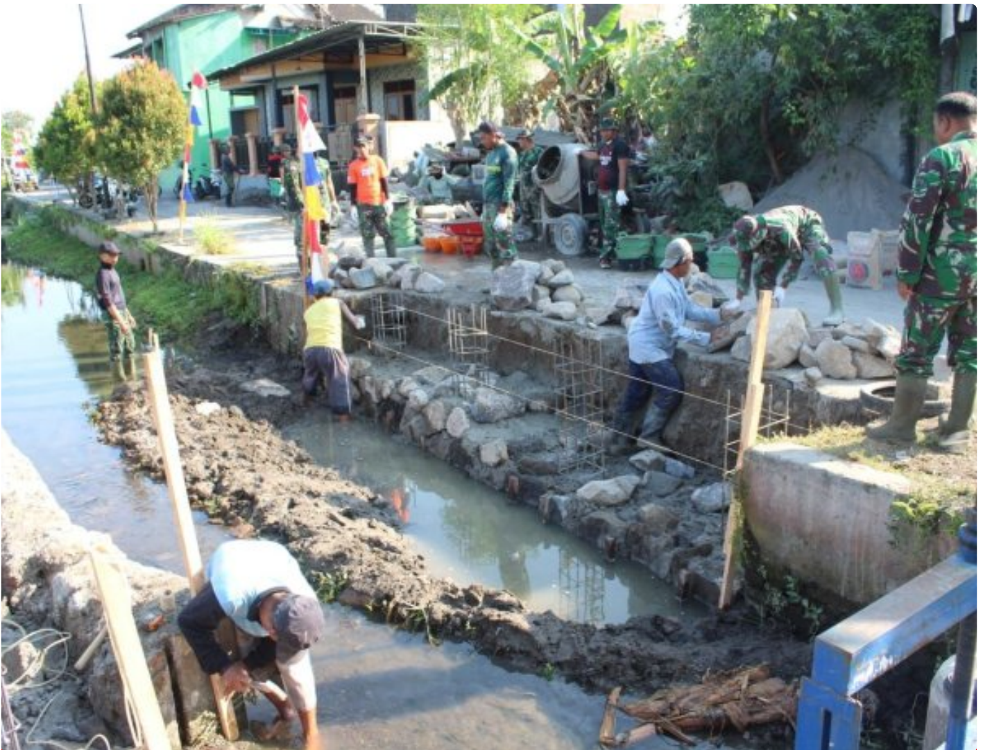
Satgas TMMD Reg 121 dan Warga Kebut Proyek Pembuatan Jembatan Program TMMD
